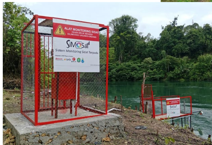
Unit SiMOSAT terpasang di tepian Sungai Poso sebagai sistem pemantauan migrasi sidat berbasis sensor hidroakustik secara real-time.
