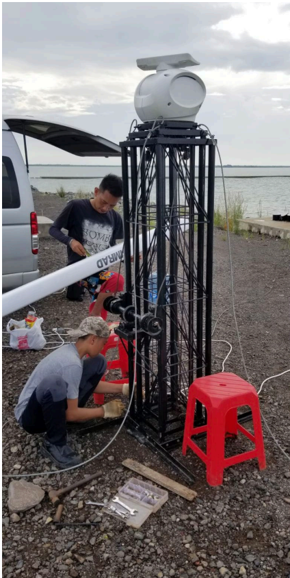
Instalasi radar X-Band di kawasan pesisir sebagai bagian dari pengumpulan data gelombang permukaan laut untuk pemetaan kedalaman perairan.
